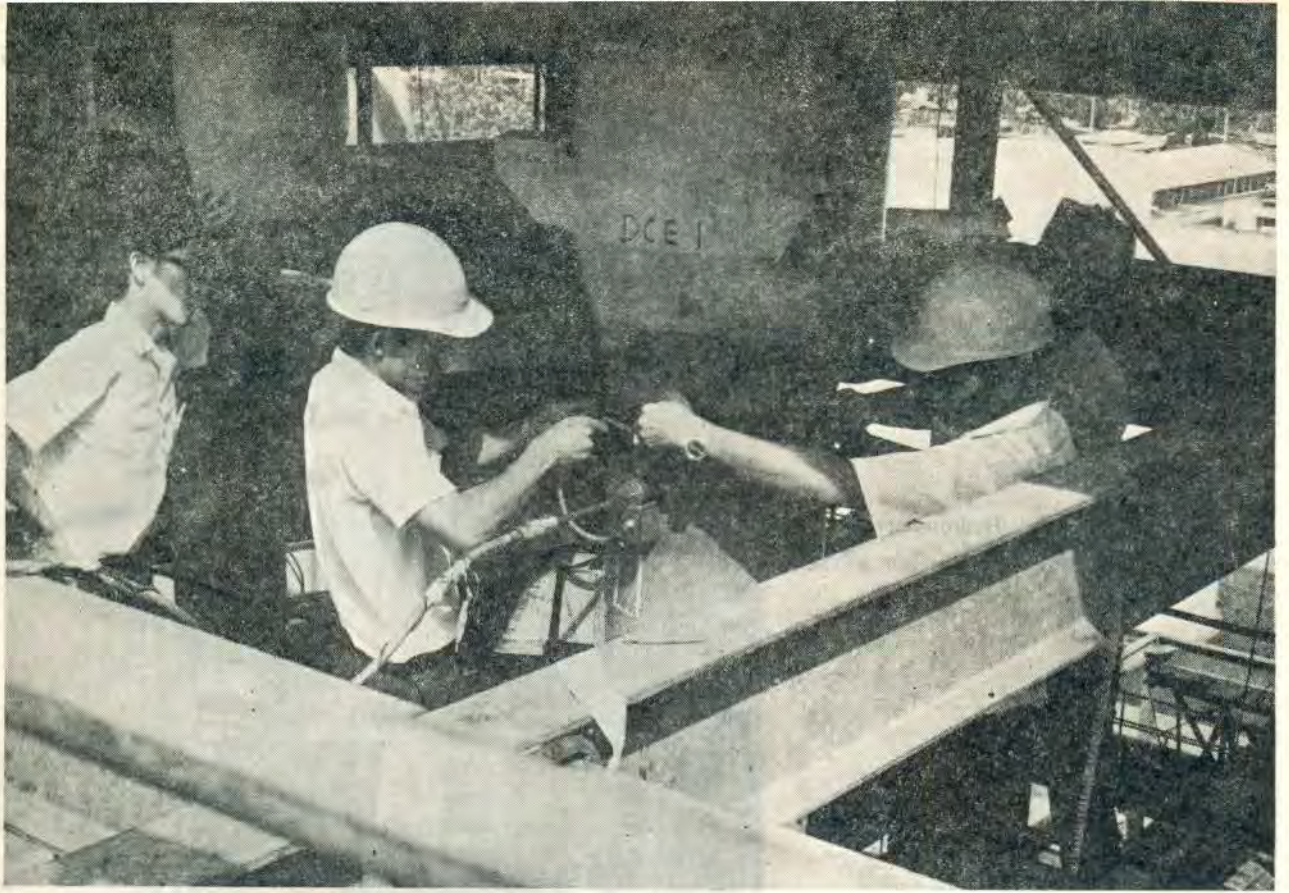
เรดิโอกราฟท่อแรงดันสูง โรงจักรพระนครใต้ เหล็กหนาประมาณ 1.5 ซม. ใช้ Ir-192
