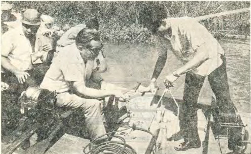
ทดลองวัดตะกอนลอย แม่น้ำป่าสัก จ.ว. สระบุรี X-RAY ATTENUATION GAUGE
