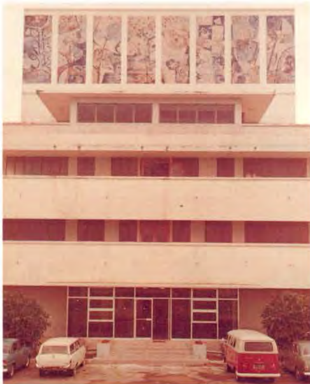
อาคารเครื่องปฏิกรณ์
