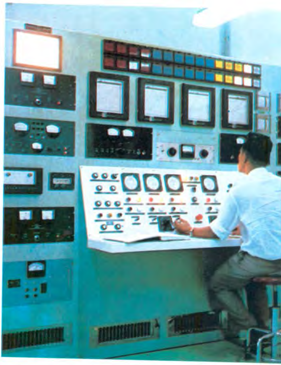
ภาพภายในห้องควบคุมเครื่องปฏิกรณ์ปรมาณู หน้าที่ต่างๆ เหล่านี้ จะแจ้งความเคลื่อนไหวของกลไกทั้งหมดได้ทันที
