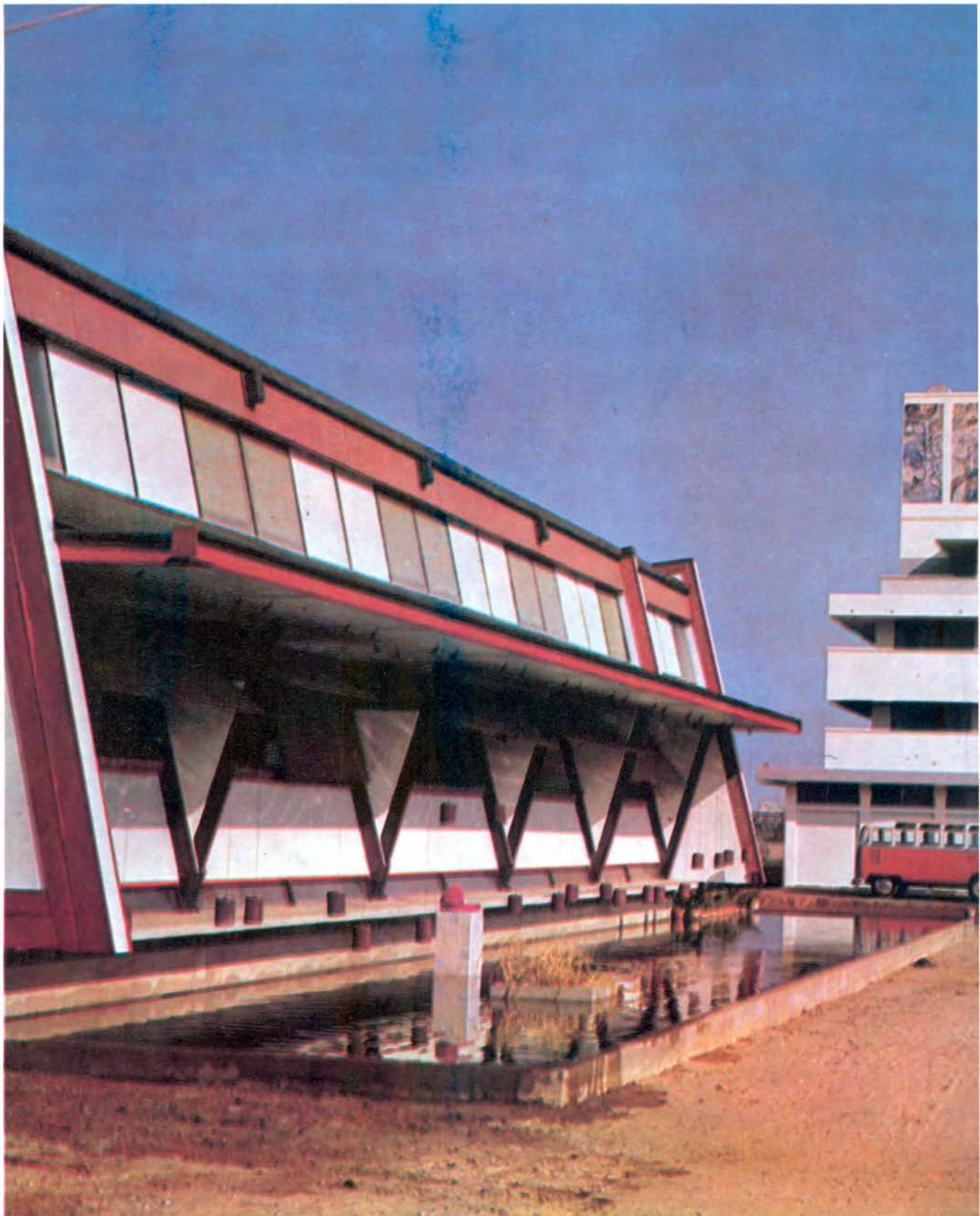
อาคารปฏิบัติการปฏิกิริยาวิจัย-๑ ซึ่งสร้างลงในบริเวณที่ดินของมหาวิทยาลัยเกษตรศาสตร์ บางเขน ด้านถนนศรีรัช เป็นอาคาร ๕ ชั้น รวมทั้งพื้นที่ชั้นล่างสุด มีส่วนของบริเวณกักอากาศตลอดทั้ง ๕ ชั้น ทางซ้ายของภาพคือ อาคารฝ่ายธุรการของสำนักงานพลังงานปรมาณูเพื่อสันติ
