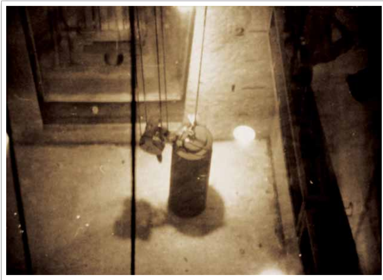
เชื้อเพลิงใช้แล้วบรรจุในคาสก์ (cask) ในบ่อปฏิกรณ์ รอการขนย้ายไปจัดเก็บในบ่อเก็บเชื้อเพลิงใช้แล้ว
