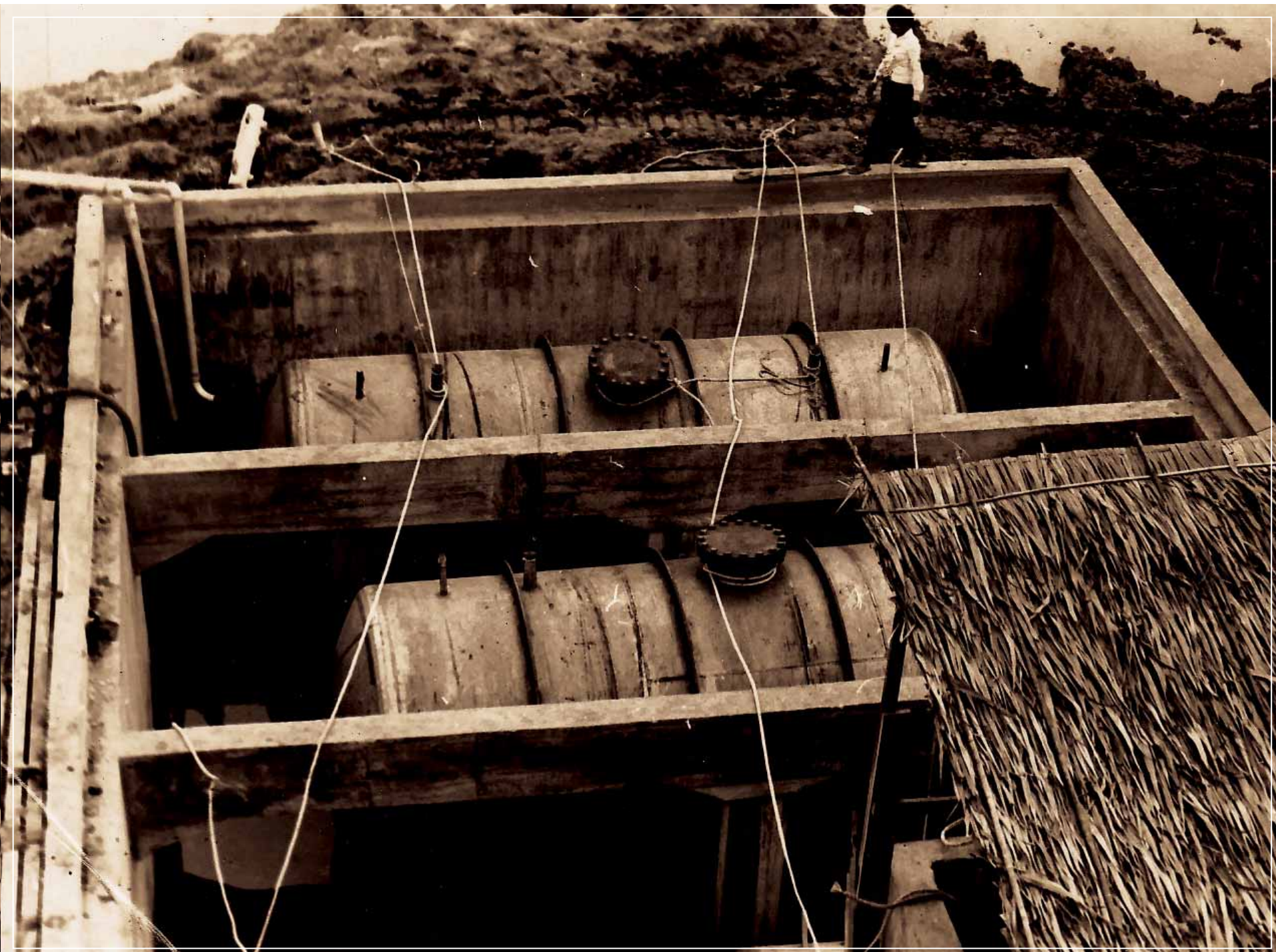
การติดตั้งถังรองรับน้ำทิ้งทางรังสี จากอาคารเครื่องปฏิกรณ์ฯ
