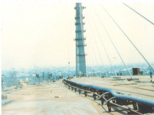
สะพานแขวนพระราม 9 ซึ่งนำเอา NOT มาตรวจสอบโครงสร้าง
