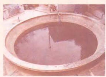
บ่อพักน้ำทิ้งทางรังสีหลังการบำบัด
