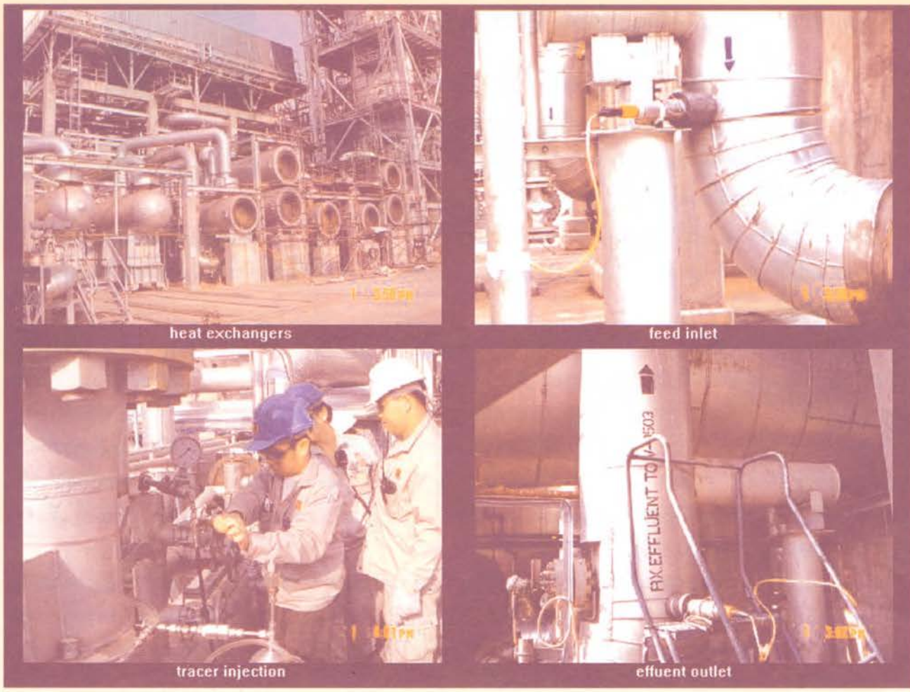
ภาพที่ 2 การตรวจสอบระบบแลกเปลี่ยนความร้อนด้วยเทคนิคสารรังสีติดตาม
