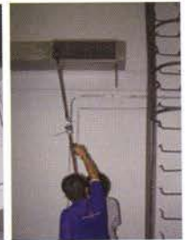
การตรวจสอบระบบระบายอากาศ
