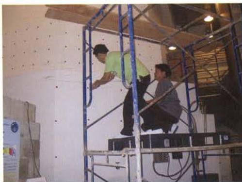
การตรวจสอบโครงสร้างบ่อเครื่องปฏิกรณ์
