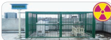
สถานีตรวจวัดอัตราปริมาณรังสีแกมมาในอากาศ
