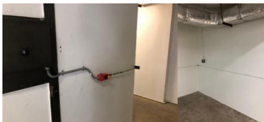
รูปที่ 14 ปุ่มฉุกเฉินและลวดสลิงที่ใช้ควบคุมให้ระบบเครื่องฉายรังสีหยุดการทำงาน
