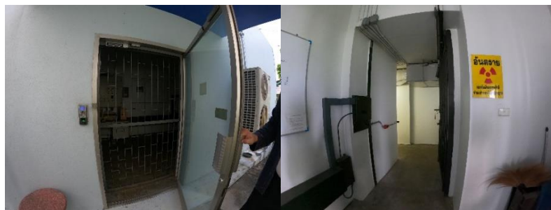
รูปที่ 3 แสดงตัวอย่างการติดตั้งประตูหลายชั้น
