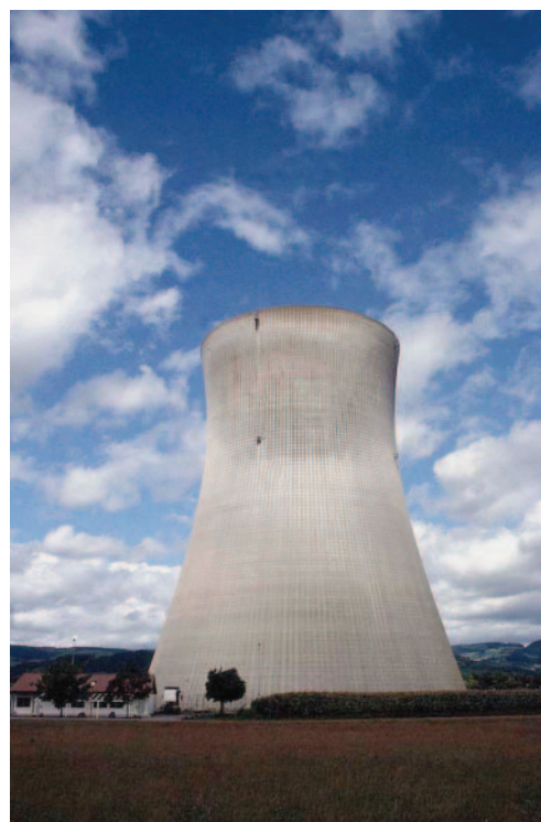
หอระบายความร้อน
