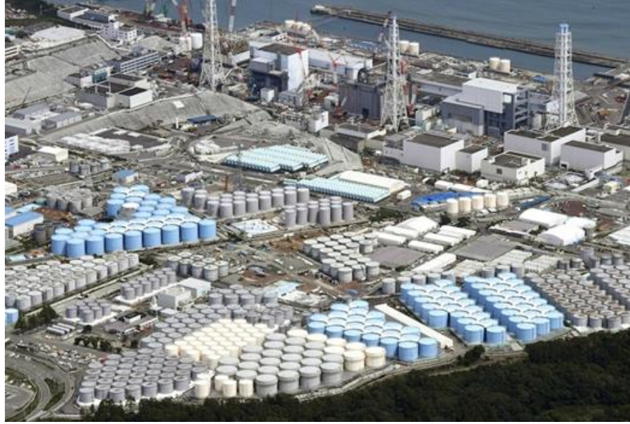
รูปที่ 2 แสดงภาพถังเก็บขนาด 1,400 ลูกบาศก์เมตร มากกว่า 1,000 ถังเก็บ ถูกรักษาความปลอดภัยในโรงไฟฟ้านิวเคลียร์ฟูกูชิมะไดอิจิ 5
