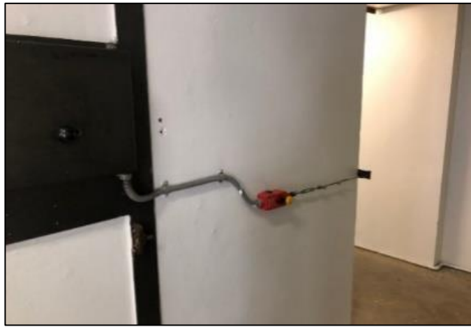
รูปที่ 5 ปุ่มฉุกเฉินและลวดสลิงที่ใช้ควบคุมให้ระบบเครื่องฉายรังสีหยุดการทำงาน
