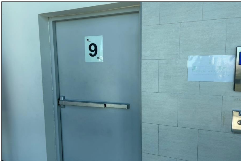
รูปภายในอาคาร
