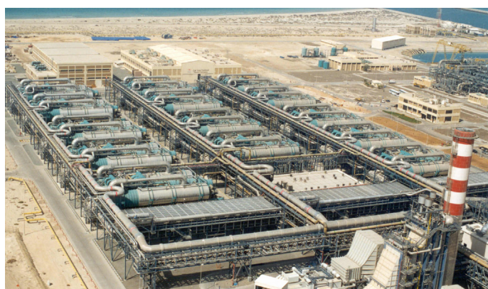
ภาพ MED units at Taweelah 1 power & desalination plant (Abu Dhabi, 2007) ที่มา: http://www.crossover.tractebel-engineering-gdfsuez.com/crossover8/expert-input-vital-desalination/
