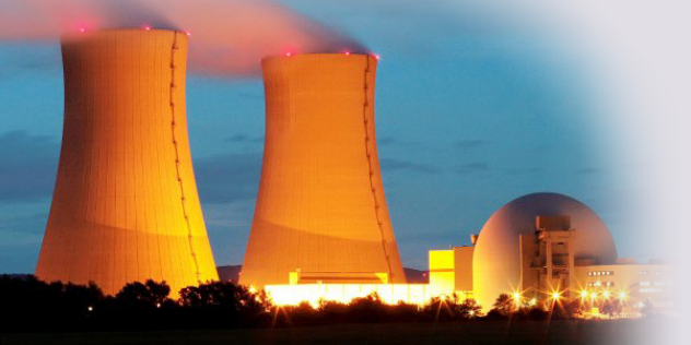
โรงเรียนไฟฟ้านิวเคลียร์ Grohnde
