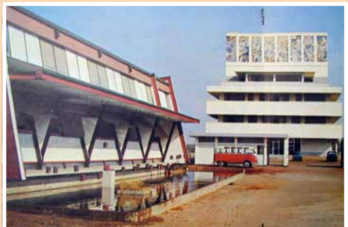
อาคารปฏิกรณ์ปรมาณูวิจัย-1 สร้างลงในบริเวณที่ดินของมหาวิทยาลัยเกษตรศาสตร์ บางเขน ด้านถนนศรีรัชมุข เป็นอาคาร 5 ชั้น รวมทั้งพื้นชั้นล่างสุดมีส่วนบริเวณที่อากาศตลอดทั้ง 5 ชั้น ทางซ้ายของภาพคือ อาคารฝ่ายธุรการของสำนักงานพลังงานปรมาณูเพื่อสันติ
